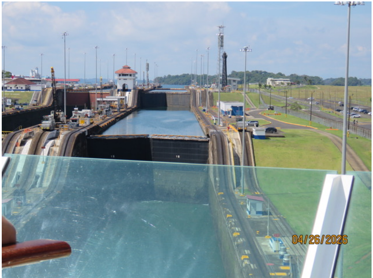
Se observan el canal original y a la derecha el nuevo
